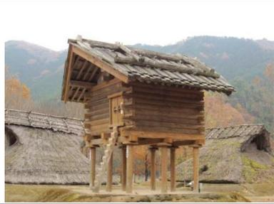
用于贮存收获的谷物。底层用栏杆架起，上面盖成房屋式样，即高出地面的房屋。
